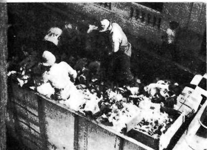
Parte del relleno experimental de Cayo Cruz. Las planchas de hierro sirven para que circulen los camiones sin que ceda el relleno, aun no consolidado.
